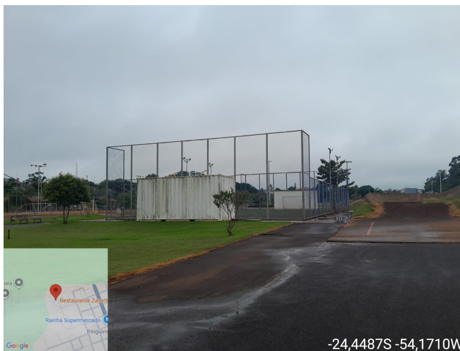
Foto 04: Estrutura existente da Quadra.
