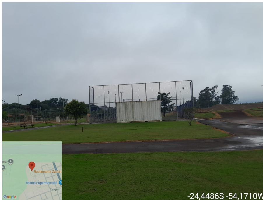
Foto 03: Estrutura existente da Quadra.
