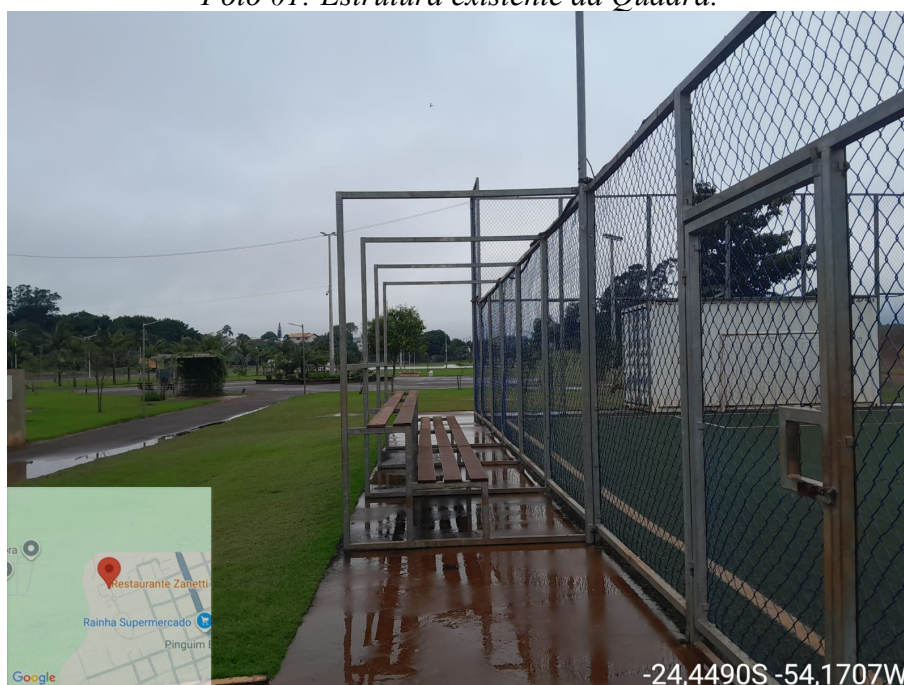
Foto 02: Estrutura existente da Quadra.
