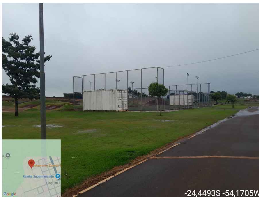
Foto 08: Estrutura existente da Quadra.
