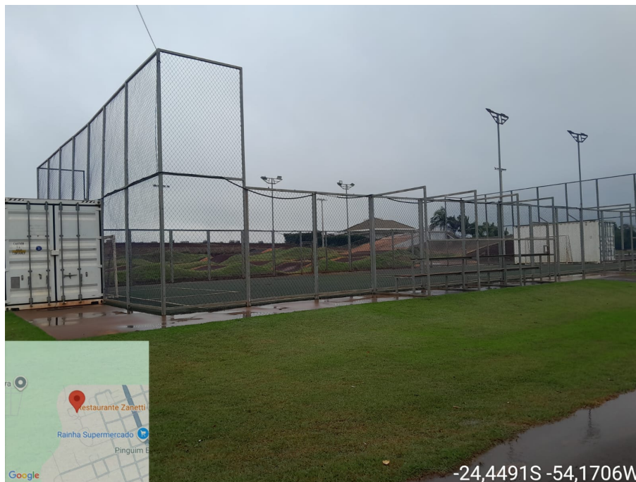
Foto 07: Estrutura existente da Quadra.
