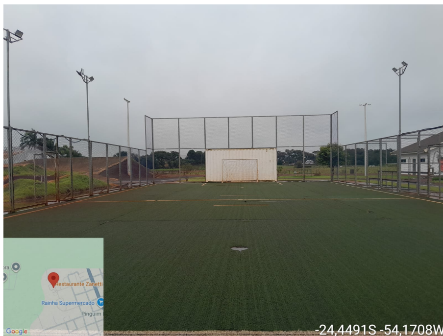
Foto 01: Estrutura existente da Quadra.
