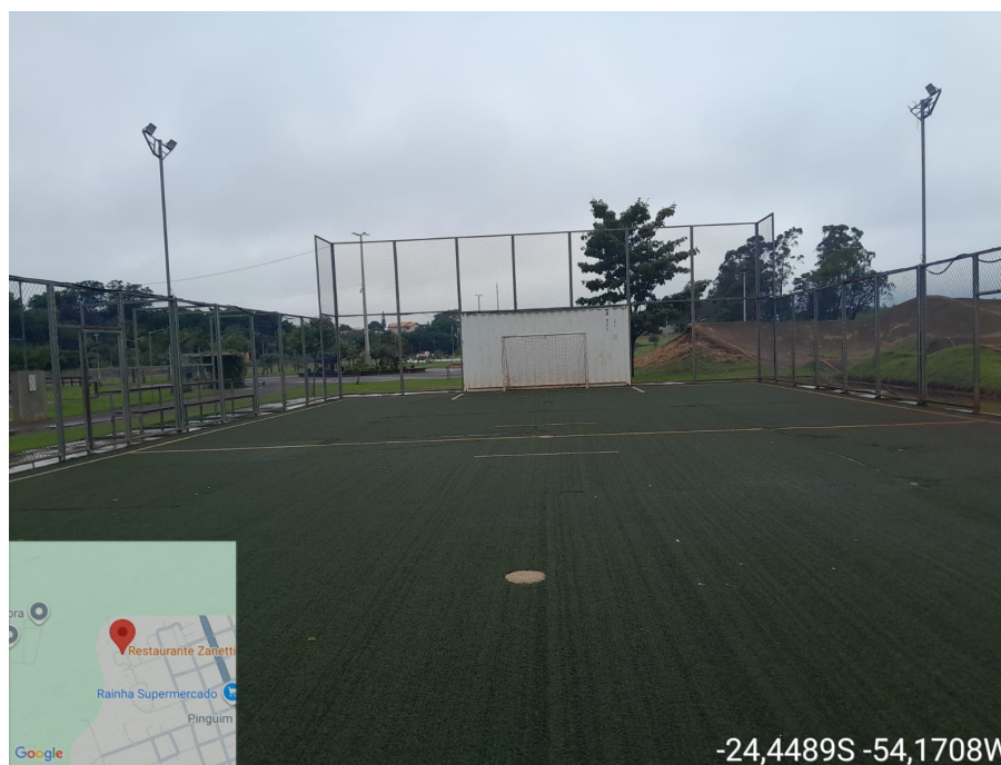
Foto 06: Estrutura existente da Quadra.
