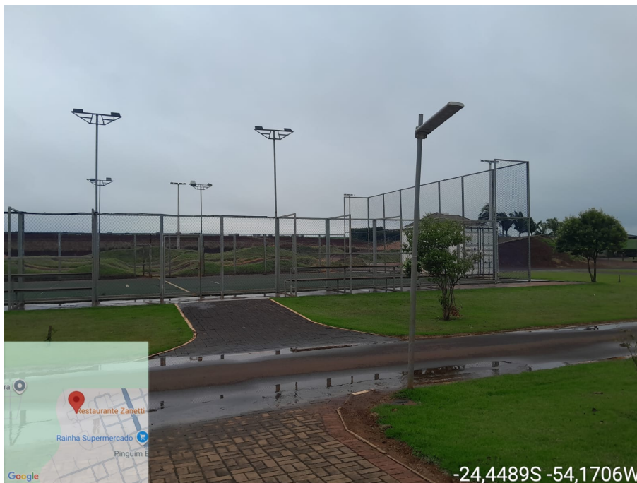
Foto 09: Estrutura existente da Quadra.
