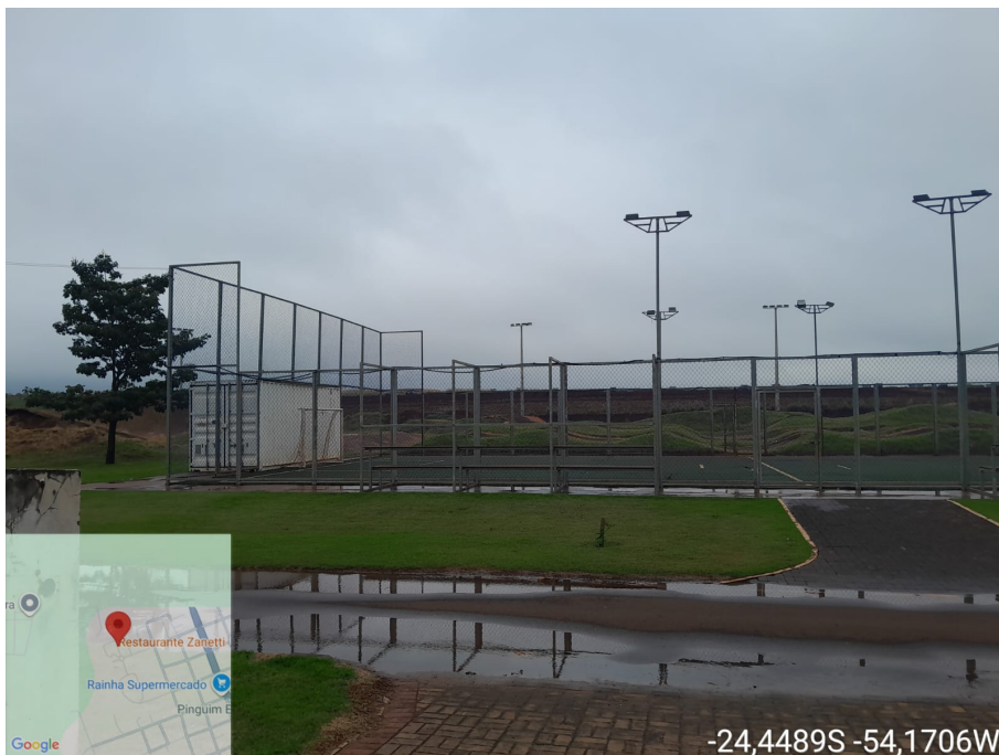
Foto 05: Estrutura existente da Quadra.
